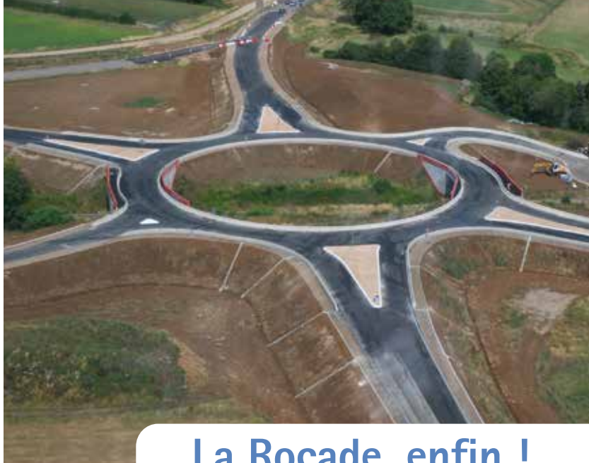
La rocade d'Avallon avec son échangeur au dessus de la voie ferrée
