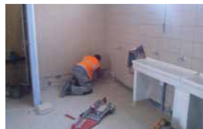
Réfection des sanitaires de l'école des Chaumes
