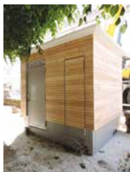
Les toilettes des Capucins le jour de leur installation.
