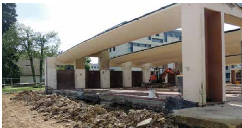
De l'ancienne structure, seuls les murs ont été conservés
