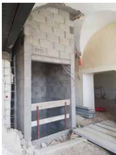
La cage qui recevra le futur ascenseur
