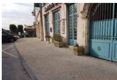
Les trottoirs de la Place Vauban
